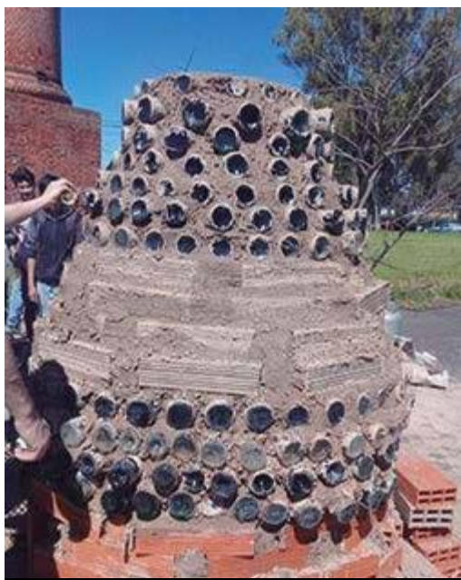
Figura 11. Horno a leña de botellas. Fotografía: Leo Glenza 9
